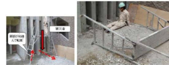
可搬式作業台の脚部を引き伸ばした際「カチ」という音でロックが掛かったと思い、天板上に上がった際、脚部伸縮部の1本が突然縮んで傾き、バランスを崩して1.6m転落。【2014年：新工】
