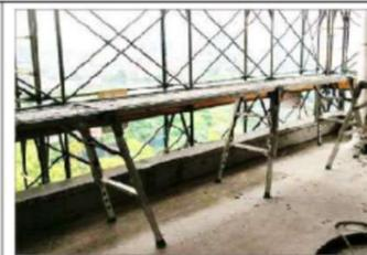
可搬式作業台を専用部材で連結
