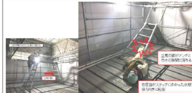
折り上げ天井の作業を行うために、構台上で可搬式作業台を利用する様に社員が指示していた。作業員は作業途中で可搬式作業台を降りる際に、作業台の脚がズれて、構台端部の隙間に脚が落ちたためステップ途中で墜落した。
