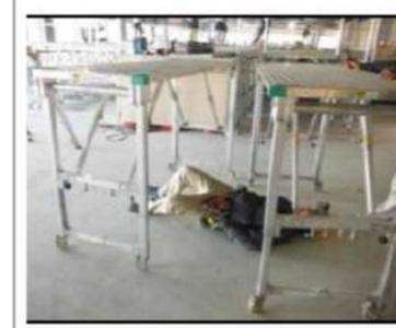
2台の作業台(ライトベース)を使用して天井ボード面の墨出し中に、上向き作業をしながら移動していた際にストッパーを掛けていない作業台に乗り移ろうとした時、作業台が動いて墜落した。
